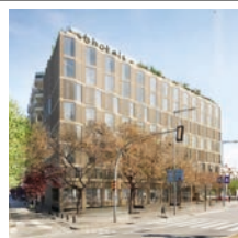
INICIO OBRAS NUEVO HOTEL EN PLAZA EUROPA Barcelona
